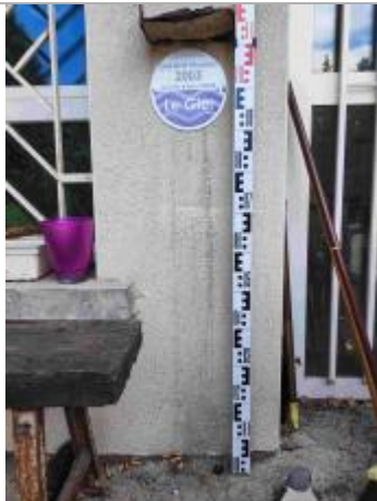
zoom sur le repère de crue posé avec une mire
