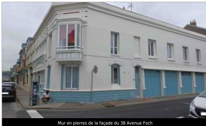
Mur en pierres de la façade du 38 Avenue Foch
