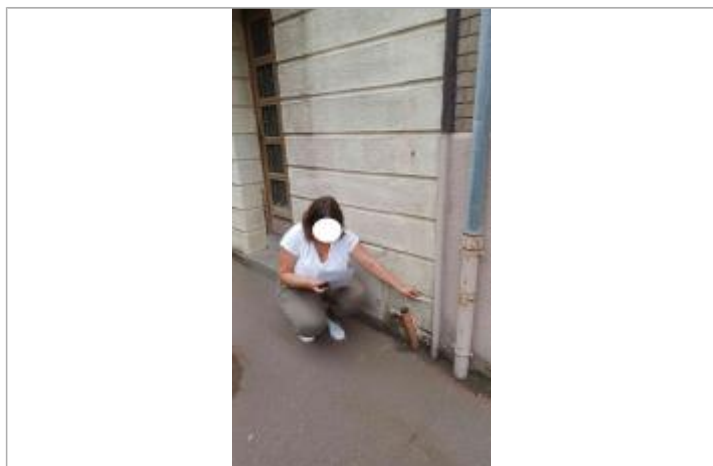
Laisse de crue au niveau de la 2ème rangée de pierre
