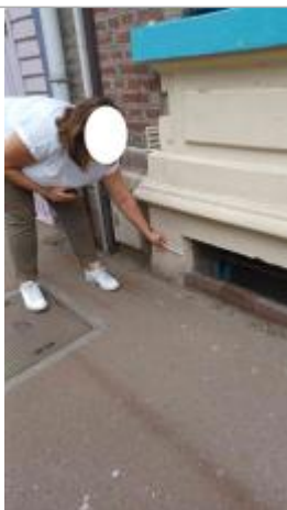
Laisse de crue à la moitié de la hauteur du soupirail.
