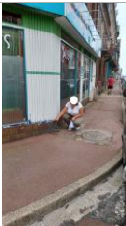
Laisse de crue en haut du carrelage
