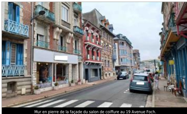
Mur en pierre de la façade du salon de coiffure au 19 Avenue Foch.
