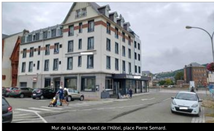
Mur de la façade Ouest de l'Hôtel, place Pierre Semard.
