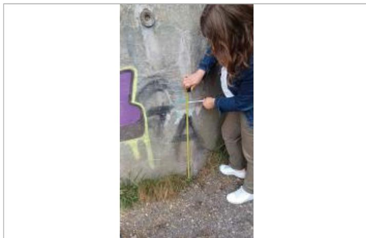
Laisse de crue sur la paroi du souterrain à 80 cm/sol.
