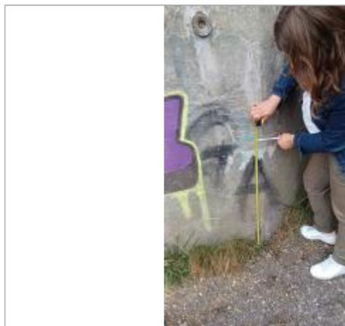
Laisse de crue sur la paroi du souterrain à 80 cm/sol.
