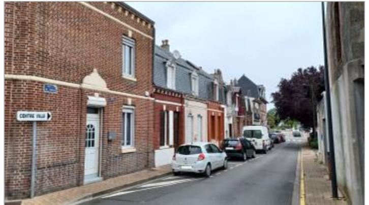
Sol de la chaussée de la Rue Ponceau, au niveau de la moitié de la rue
