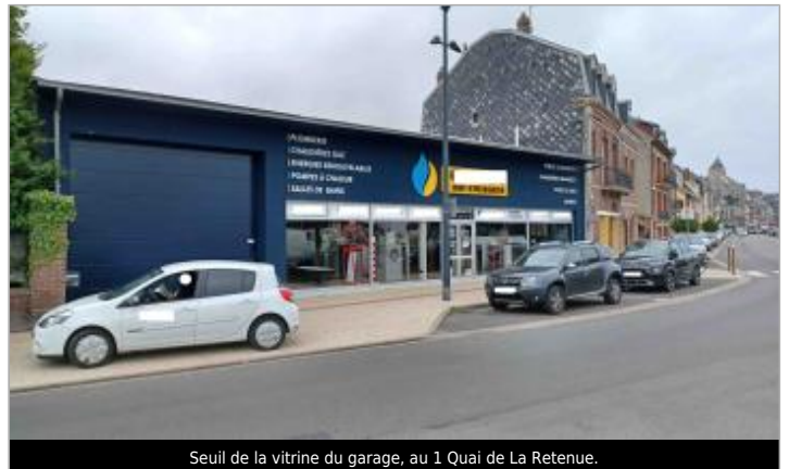
Seuil de la vitrine du garage, au 1 Quai de La Retenue.
