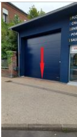
Seuil de la vitrine du garage, au 1 Quai de La Retenue.
