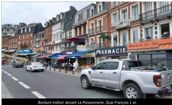
Bordure trottoir devant La Poissonnerie, Quai François 1 er .
