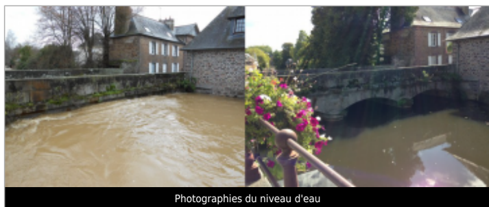
Photographies du niveau d'eau
