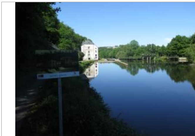
Bâtiment accolé à la maison éclusière du Roch, vue d'ensemble
