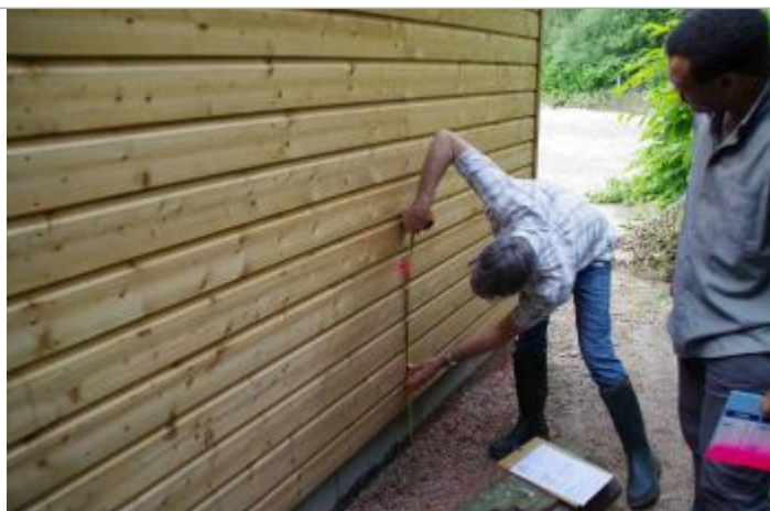
Mesure de la marque au niveau de la 5ème planche en partant du bas (Source : DDT 61)
