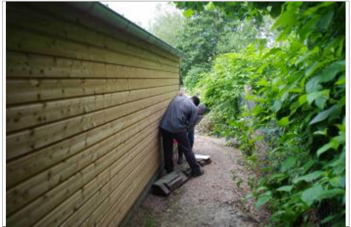
Arrière de l'annexe du local situé sur le boulodrome (Source : DDT 61)
