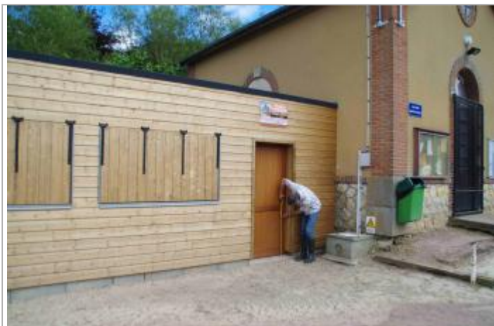
Annexe du local du Boulodrome (Source: DDT 61)
