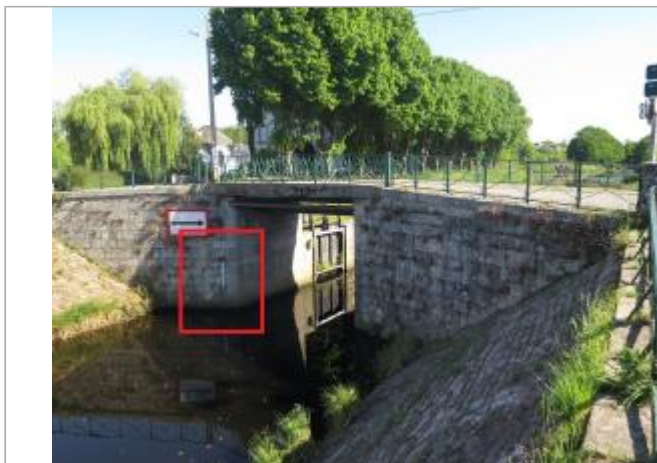
Aval de l'écluse des Recollets à Pontivy
