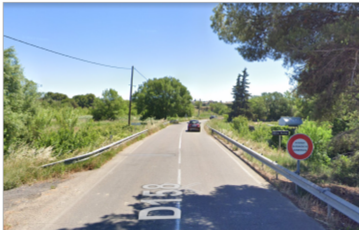
Pont sur le Pallas en direction de Loupian
