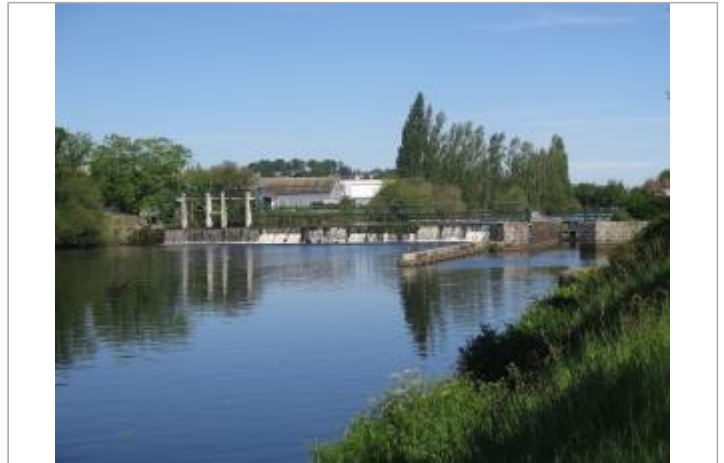
Aval de l'écluse de Lestitut à Pontivy
