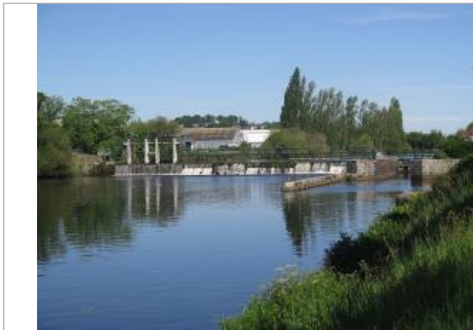
Aval de l'écluse de Lestitut à Pontivy
