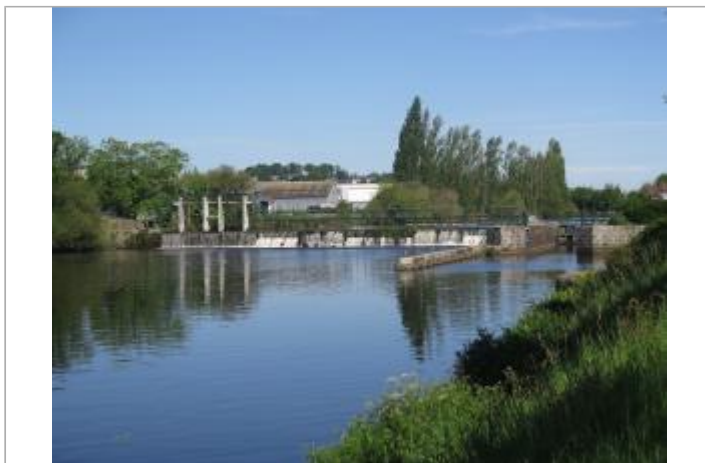
Aval de l'écluse de Lestitut à Pontivy
