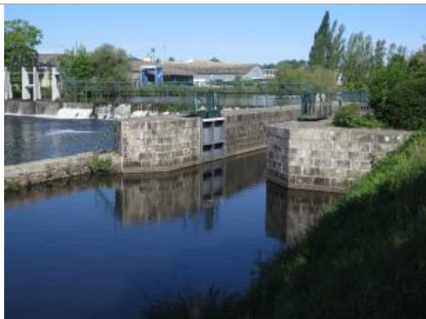
Echelle aval disparue de l'écluse de Lestitut à Pontivy
