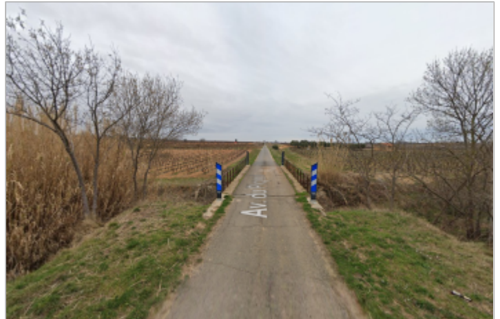
Pont sur le Soupié en direction de Mèze
