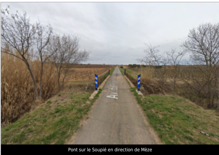
Pont sur le Soupié en direction de Mèze
