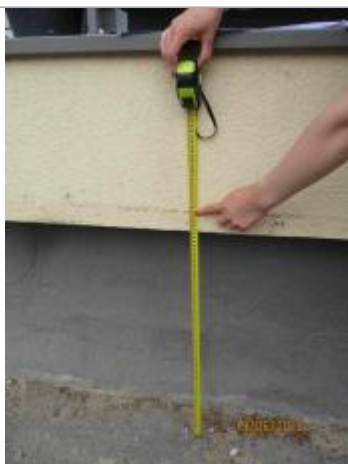
Mesure de la marque au niveau de l'immeuble à partir du trottoir (source : DDT 61)
