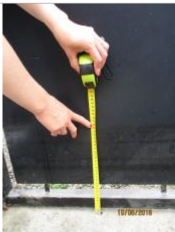
Mesure de la laisse par rapport à la dalle en béton du portail (source : DDT 61)
