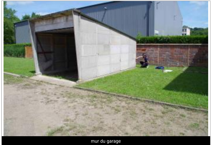
mur du garage
