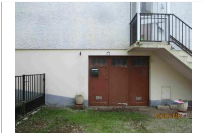
Vue de la porte de garage (source : DDT 61)
