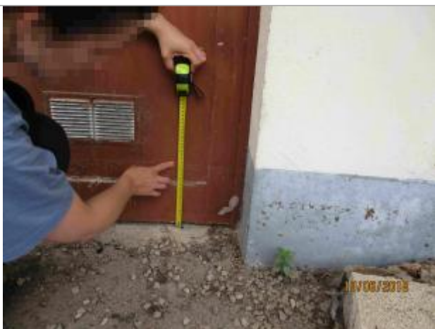
Mesure de la marque au niveau de la porte de garage à 25 cm/sol (source : DDT 61)
