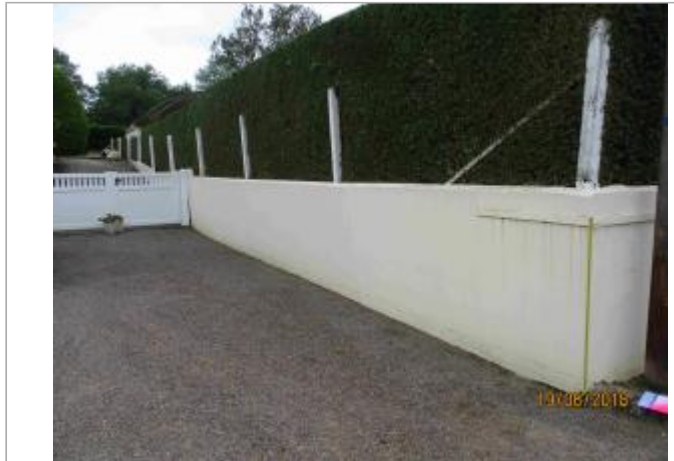
Mur de contrefort menant à un portail blanc (source : DDT 61)
