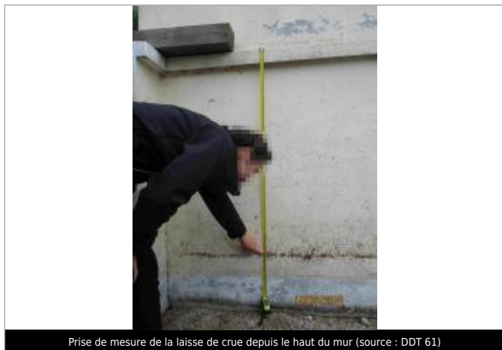
Prise de mesure de la laisse de crue depuis le haut du mur (source : DDT 61)
