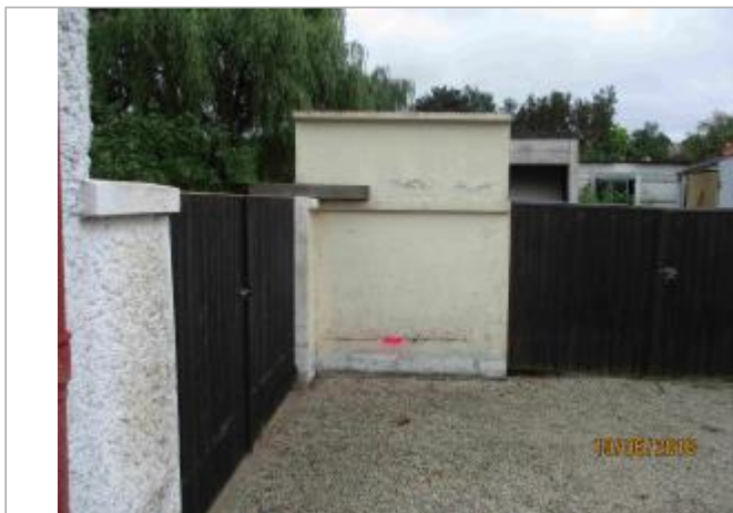
Vue du mur depuis la cour de la copropriété (Source : DDT 61)
