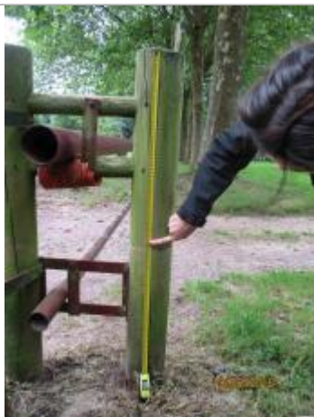
Vue de la mesure prise depuis le haut du poteau (source : DDT 61)
