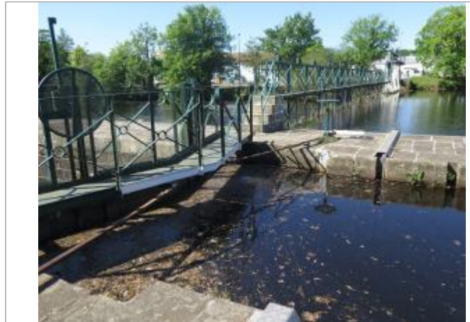
Amont de l'écluse de Lestitut à Pontivy
