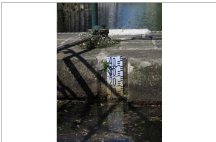
Echelle amont de l'écluse de Lestitut
