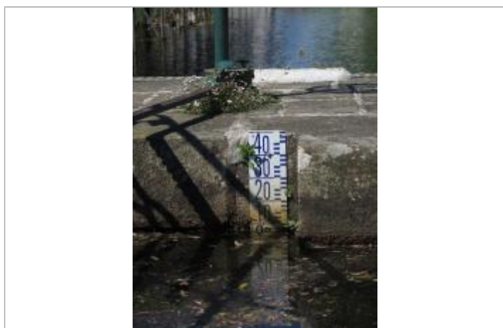
Echelle amont de l'écluse de Lestitut
