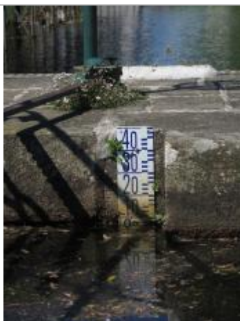
Echelle amont de l'écluse de Lestitut
