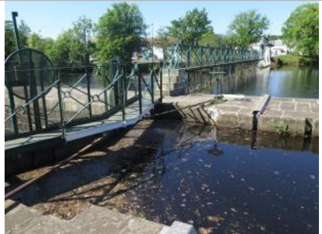
Amont de l'écluse de Lestitut à Pontivy
