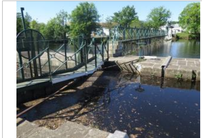
Amont de l'écluse de Lestitut à Pontivy
