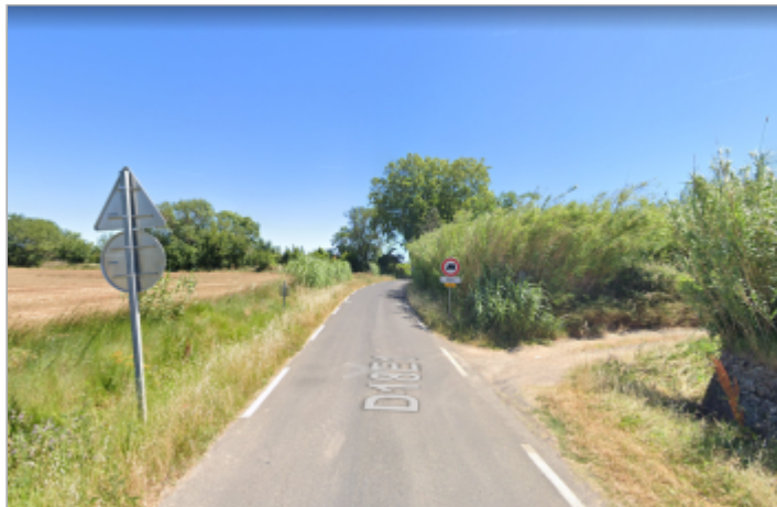
Départementale en rive droite du Soupié
