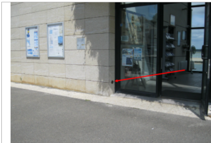
repère de crue de la Capitainerie du Croisic
