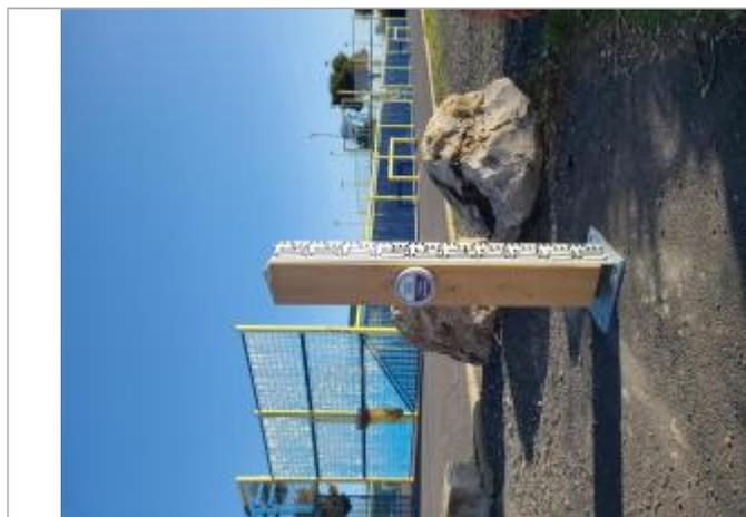
Totem de crue monté du repère de crue et d'une échelle graduée, au bord du canal
