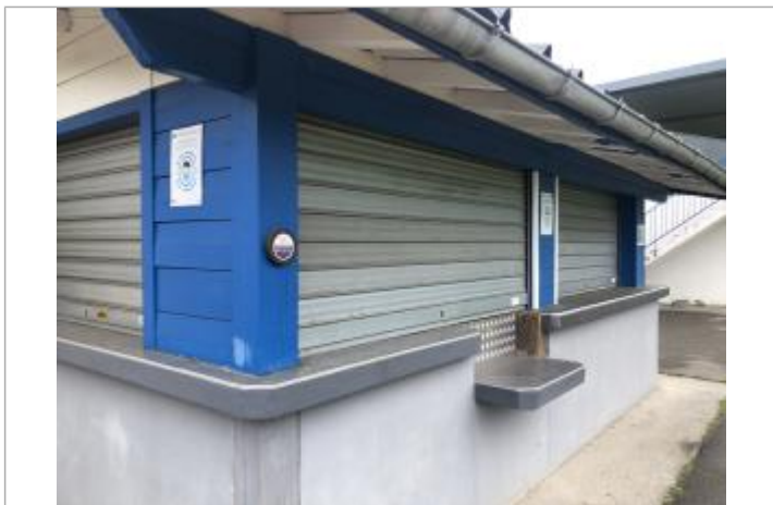
Repère sur le pilier Ouest de la buvette
