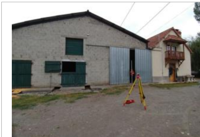
Levée de la laisse côté sud du bâtiment
