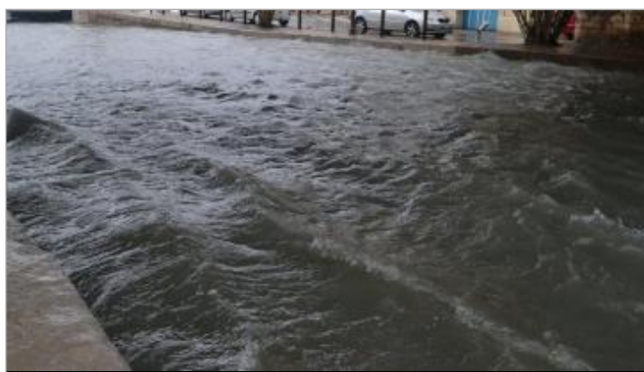
Canal plein sous le passage de la voie ferrée
