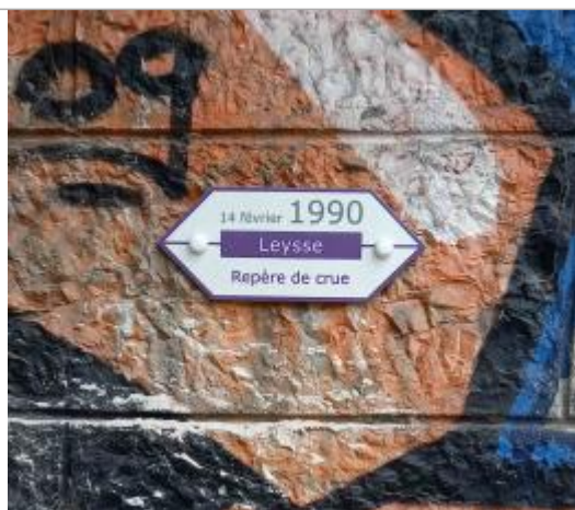
Repère de crue 14 février 1990
