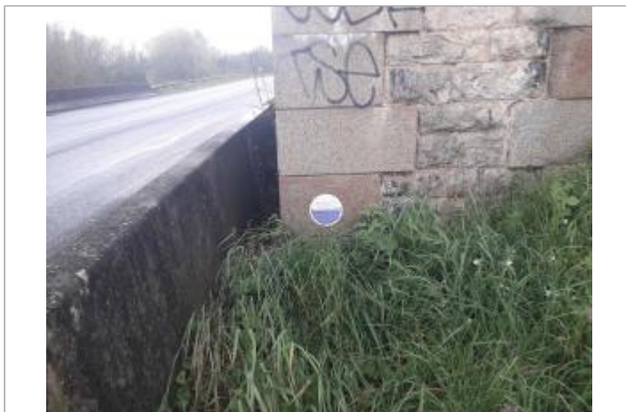
Pile de Pont SNCF
