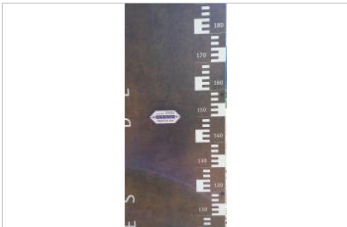
Repère de crue 18 janvier 1955
