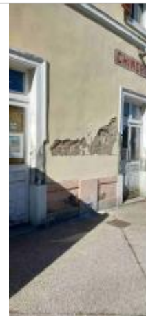
Gare de Chindrieux
