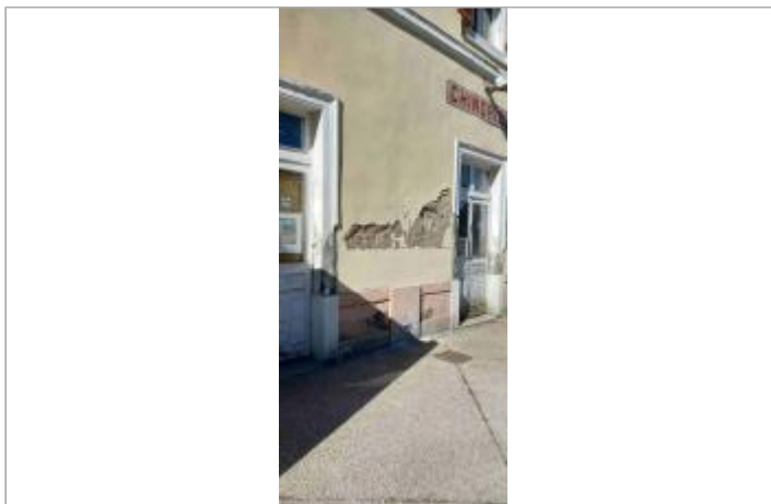
Gare de Chindrieux
