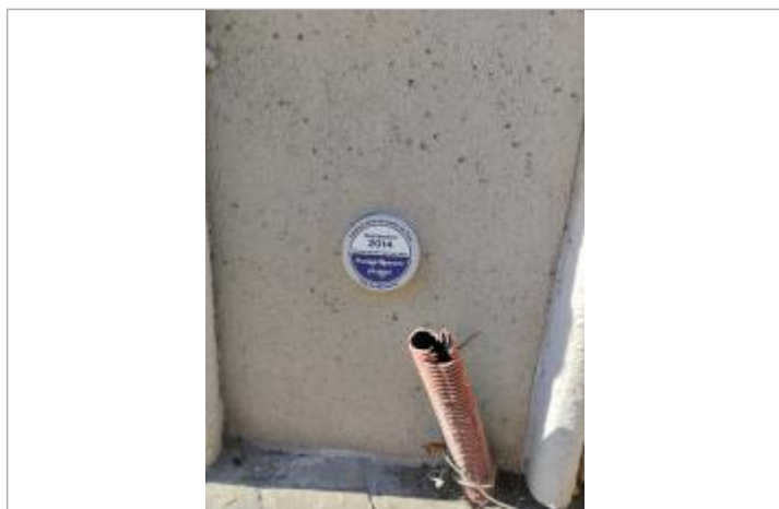
Repère de crue sur la façade de l'opticien
