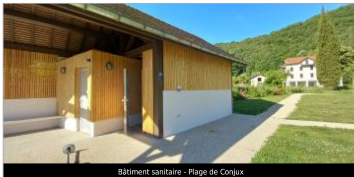
Bâtiment sanitaire - Plage de Conjux
