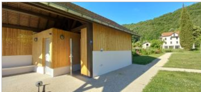
Bâtiment sanitaire - Plage de Conjux
