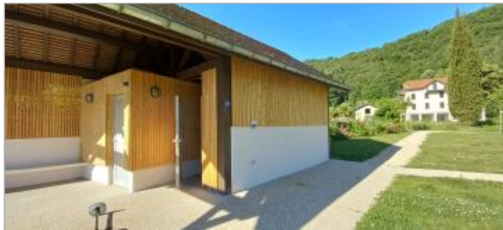
Bâtiment sanitaire - Plage de Conjux
