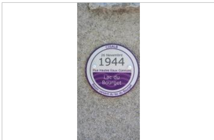
Repère de crue 26 novembre 1944
