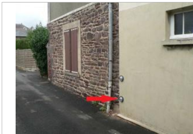
Repère normalisé de la crue de février 2010 - Xynthia
